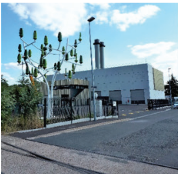
Vue d'ensemble de la chaufferie urbaine au Menetton
