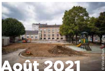
Début des travaux de débitumisation de la cour.
