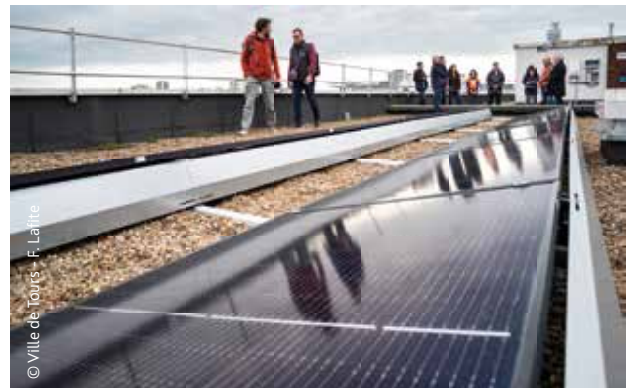
L'implantation de panneaux photovoltaïques va se déployer en 2023.
