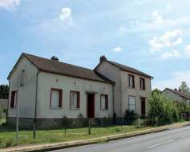
Le long de la route départementale, deux types de logements sont associés pour marquer de façon symétrique les entrées dans la cité-jardin.
