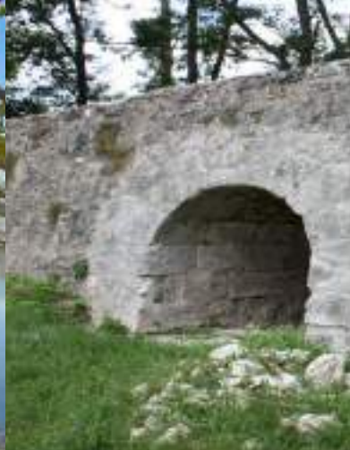
Le déversoir de la Bouillie.
