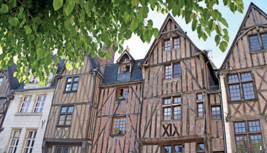
1. Maisons en pans de bois de la place Plumereau
