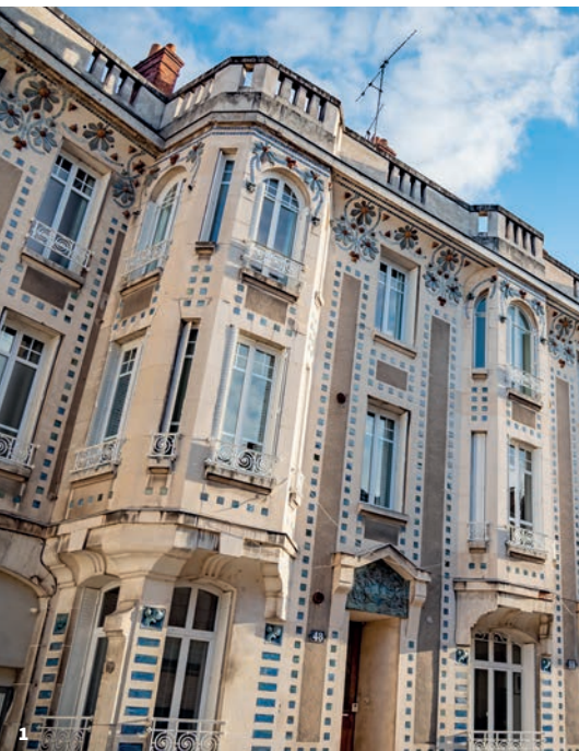
1. Façade de l'immeuble Duthoo, avec son ornementation en céramique
