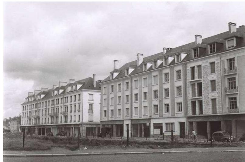
*Exemple de caractères d'origine à conserver ou restituer : trois étages carrés sur rez-de-chaussée souligné par un bandeau filant continu. Marquage vertical des travées de baies. Façades enduites, corniche filante, toit à quatre pentes, lucarnes à croupes axées sur les travées, cheminées béton...*
