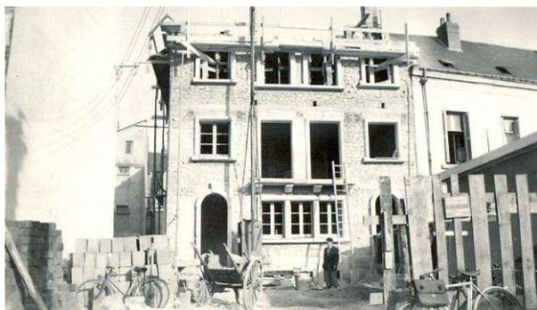
*Construction en maçonnerie de moellons et modénature de ciment moulé. Source : direction de l'inventaire du patrimoine de la Région Centre, 2011.*
