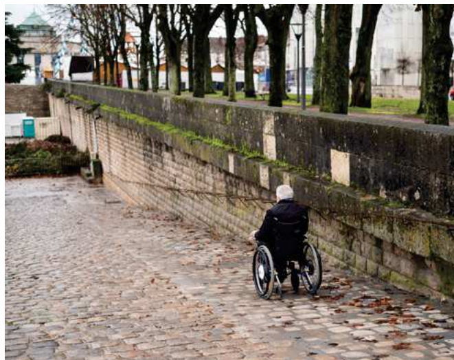
Rampe PMR © Ville de Tours - F. Lafite
