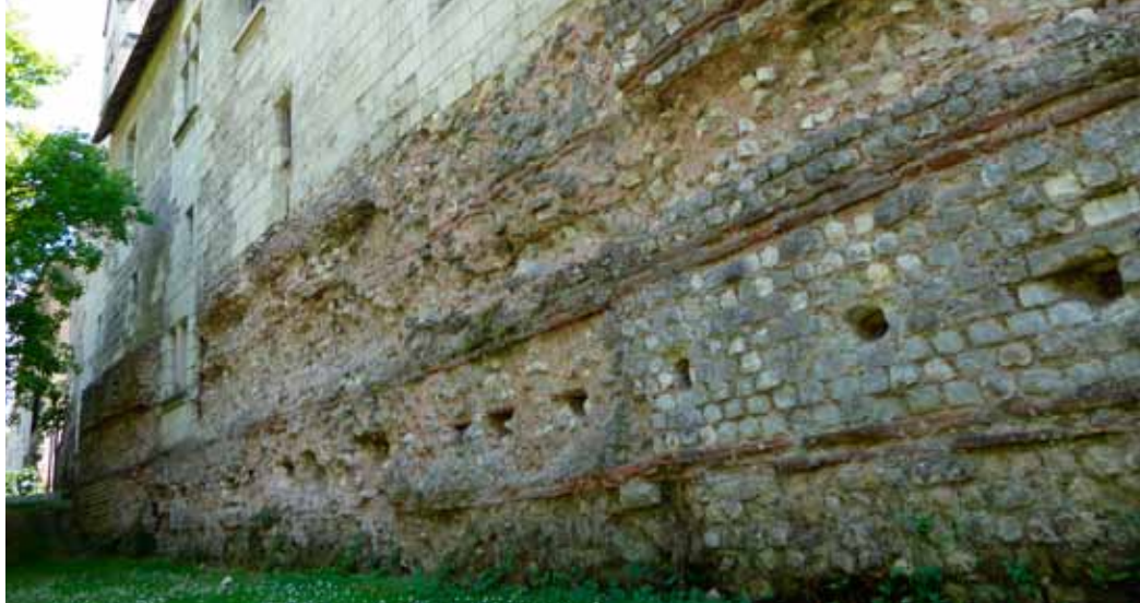
Le rempart antique sous le logis des Gouverneurs © Ville de Tours
